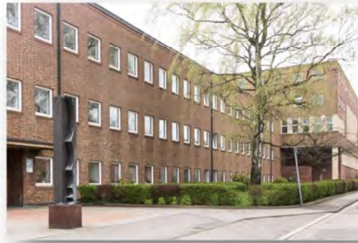
Dienstgebäude in Kiel, Fröbelstraße 15 - 17
